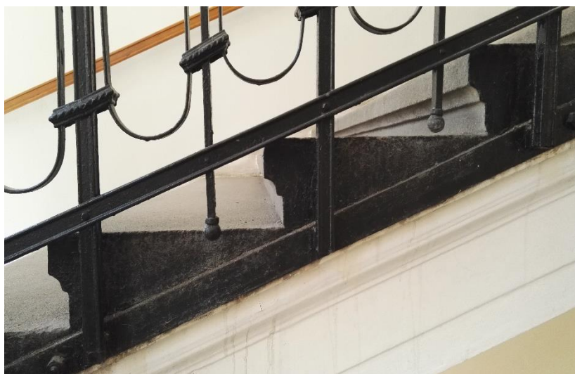
Boční strana schodnic opatřená nátěrem stejným, jako zábradlí, detail
